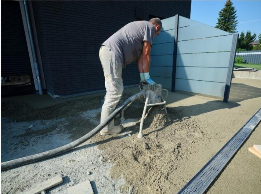
Auftragen des Drainestrichs PCI Pavifix DM mit Pumptechnik (Estromat) ([LINK](#) zum Photo)
