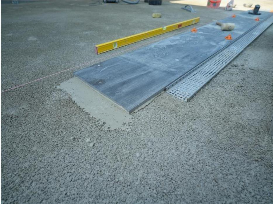
Ausloten und Verlegen der Terrassenplatten nebst Entwässerungsrinne ([LINK](#) zum Photo)
