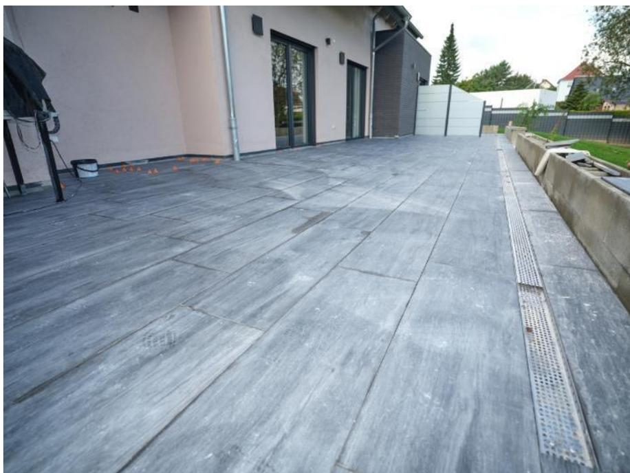
Komplett sanierte Terrasse aus Feinsteinzeug mit Entwässerungsrinne ([LINK](#) zum Photo)
