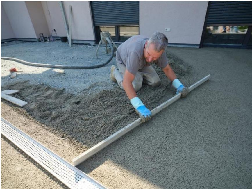
Gleichmäßiges Verlegen des Drainestrichs PCI Pavifix DM ([LINK](#) zum Photo)
