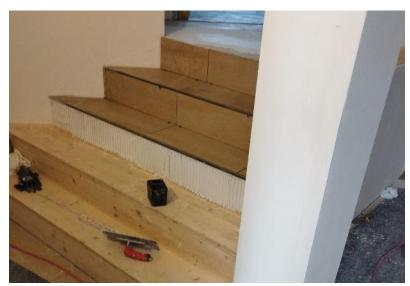
Der Kleber reagiert mit Luft- oder Untergrundfeuchtigkeit, was eine sichere und schnelle Aushärtung gewährleistet (<u>LINK</u> zum Photo)
