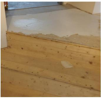
Da PCI Flexcoll keine Grundierung erfordert, kann der Kleber nach Abschliff und Reinigung des Untergrunds direkt aufgetragen werden. (<u>LINK</u> zum Photo)
