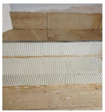
Aufgrund der besonderen Beanspruchung der Treppe wurde die Verlegung im kombinierten Verfahren durchgeführt. (<u>LINK</u> zum Photo)
