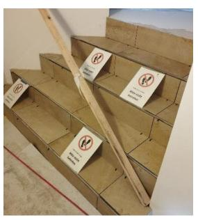
Mit PCI Flexcoll verlegte Beläge können nach einem Tag belastet werden. Somit konnte die Treppe bereits einen Tag nach der Belegung verfugt und nach der Trocknung des Fugenmaterials freigegeben werden. (LINK zum Photo)
